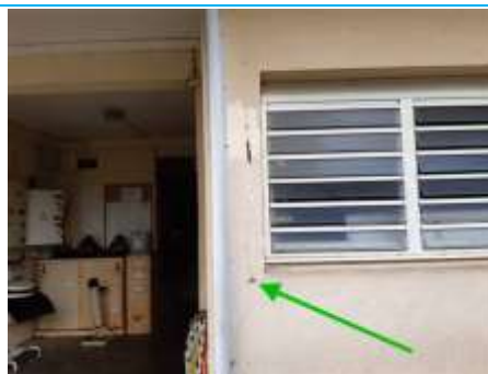
Matériaux : M012 Prélèvement : P012 Description : P012 - Enduit mur est Localisation : Bâtiment 3 - Façade Est Résultat : Absence d'amiante
