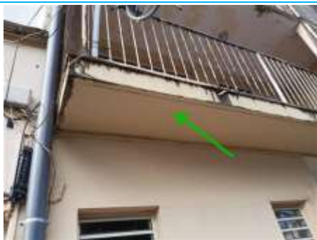
Matériaux : M007 Prélèvement : P007 Description : P007 - Enduit sous face balcon Localisation : Bâtiment 3 - Façade Est Résultat : Absence d'amiante
