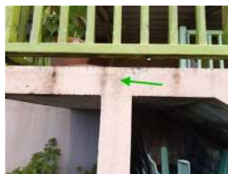
Matériaux : M030 Prélèvement : P030 Description : P030 - Enduit escalier terrasse Localisation : Bâtiment 3 - Façade Ouest Résultat : Absence d'amiante
