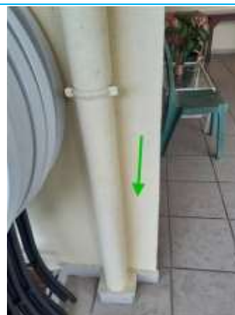
Matériaux : M028 Prélèvement : P028 Description : P028 - Enduit mur ouest cuisine Localisation : Bâtiment 3 - Façade Ouest Résultat : Absence d'amiante
