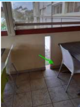
Matériaux : M025 Prélèvement : P025 Description : P025 - Enduit garde corps terrasse Localisation : Bâtiment 3 - Façade Ouest Résultat : Absence d'amiante
