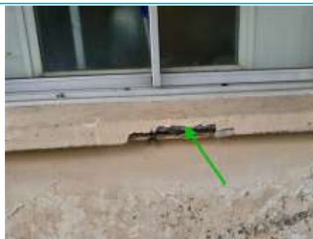
Matériaux : M010 Prélèvement : P010 Description : P010 - Enduit appui de fenêtre cuisine Localisation : Bâtiment 3 - Façade Est Résultat : Absence d'amiante
