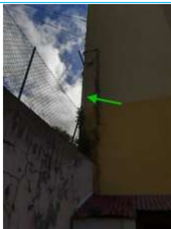
Matériaux : M017 Prélèvement : P017 Description : P017 - Enduit mur pignon nord est Localisation : Bâtiment 3 - Pignon Nord Résultat : Absence d'amiante
