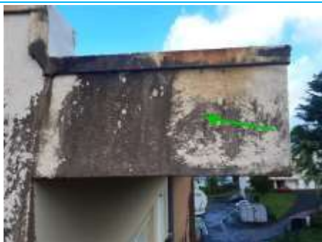
Matériaux : M001 Prélèvement : P001 Description : P001 - Enduit casquette Est Localisation : Bâtiment 3 - Façade Est Résultat : Absence d'amiante
