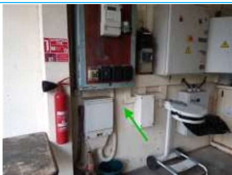
Matériaux : M011 Prélèvement : P011 Description : P011 - Enduit mur compteur électrique Localisation : Bâtiment 3 - Façade Est Résultat : Absence d'amiante
