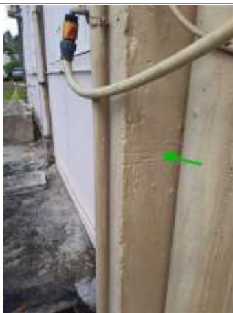
Matériaux : M021 Prélèvement : P021 Description : P021 - Enduit poteau ouest Localisation : Bâtiment 3 - Façade Ouest Résultat : Absence d'amiante
