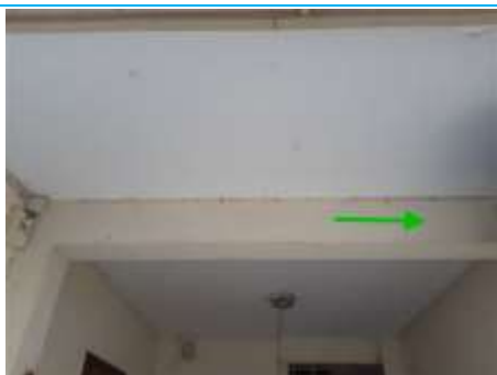
Matériaux : M009 Prélèvement : P009 Description : P009 - Enduit poutre escalier sud Localisation : Bâtiment 3 - Façade Est Résultat : Absence d'amiante
