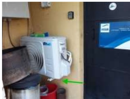
Matériaux : M018 Prélèvement : P018 Description : P018 - Enduit mur clim pignon nord Localisation : Bâtiment 3 - Pignon Nord Résultat : Absence d'amiante
