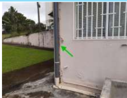
Matériaux : M020 Prélèvement : P020 Description : P020 - Enduit mur coin nord ouest Localisation : Bâtiment 3 - Façade Ouest Résultat : Absence d'amiante
