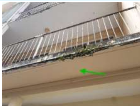
Matériaux : M014 Prélèvement : P014 Description : P014 - Enduit sous face balcon Localisation : Bâtiment 3 - Façade Est Résultat : Absence d'amiante
