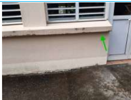
Matériaux : M006 Prélèvement : P006 Description : P006 - Enduit mur fenêtre messe Localisation : Bâtiment 3 - Façade Est Résultat : Absence d'amiante
