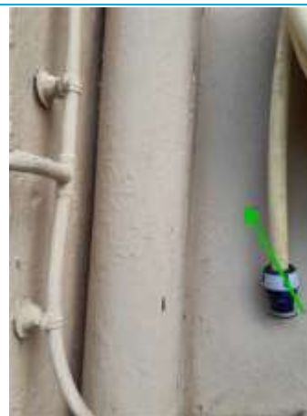
Matériaux : M022 Prélèvement : P022 Description : P022 - Enduit mur ouest Localisation : Bâtiment 3 - Façade Ouest Résultat : Absence d'amiante
