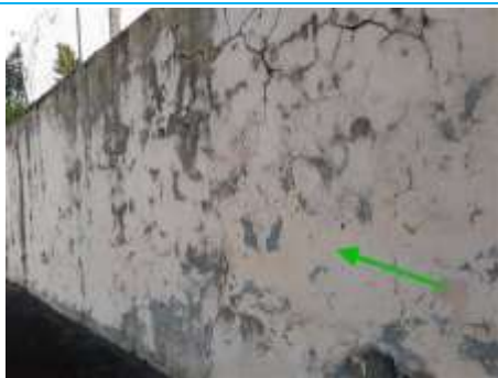
Matériaux : M019 Prélèvement : P019 Description : P019 - Enduit mur soutènement nord Localisation : Bâtiment 3 - Façade Ouest Résultat : Absence d'amiante
