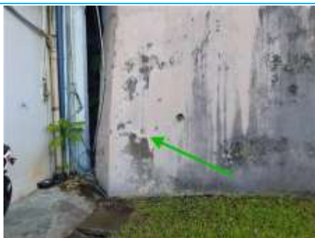
Matériaux : M023 Prélèvement : P023 Description : P023 - Enduit mur terrasse ordinaire Localisation : Bâtiment 3 - Façade Ouest Résultat : Absence d'amiante
