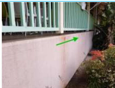
Matériaux : M024 Prélèvement : P024 Description : P024 - Enduit mur ouest terrasse ordinaire Localisation : Bâtiment 3 - Façade Ouest Résultat : Absence d'amiante
