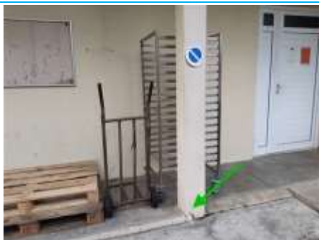
Matériaux : M013 Prélèvement : P013 Description : P013 - Enduit poteau est Localisation : Bâtiment 3 - Façade Est Résultat : Absence d'amiante
