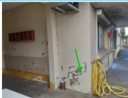
Matériaux : M008 Prélèvement : P008 Description : P008 - Enduit mur escalier sud Localisation : Bâtiment 3 - Façade Est Résultat : Absence d'amiante
