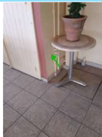
Matériaux : M026 Prélèvement : P026 Description : P026 - Enduit mur nord est terrasse Localisation : Bâtiment 3 - Façade Ouest Résultat : Absence d'amiante
