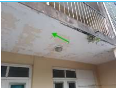
Matériaux : M003 Prélèvement : P003 Description : P003 - Enduit plafond balcon Localisation : Bâtiment 3 - Façade Est Résultat : Absence d'amiante
